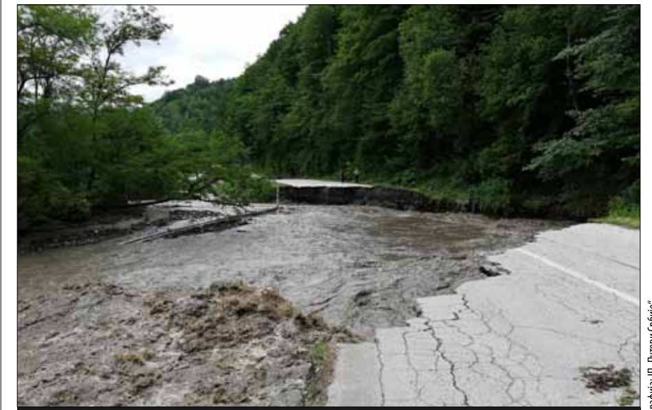
Оштећења на деоници Ариље – Ивањица након поплава
